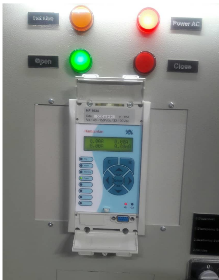
شکل 5: قرار گرفتن رله داخل کیس
