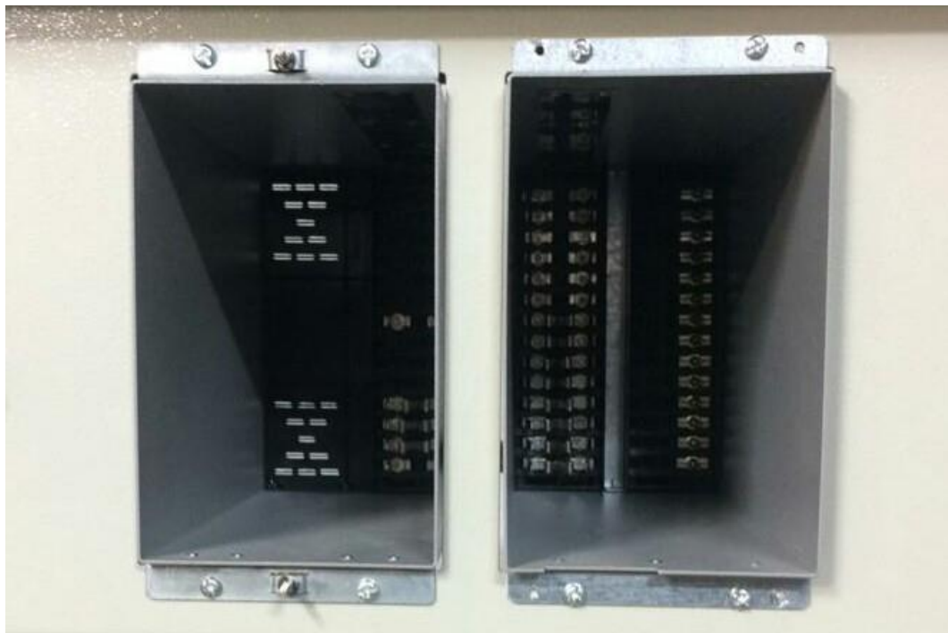
شکل 3: نصب کیس رله و کیس منبع تغذیه در تابلو
