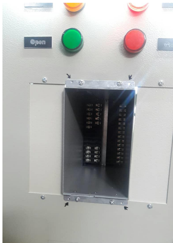
شکل 2: نصب کیس رله در تابلو
