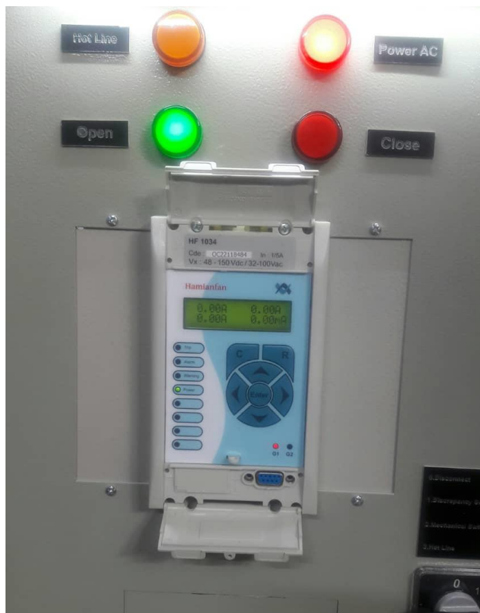
شکل 5: قرار گرفتن رله داخل کیس
